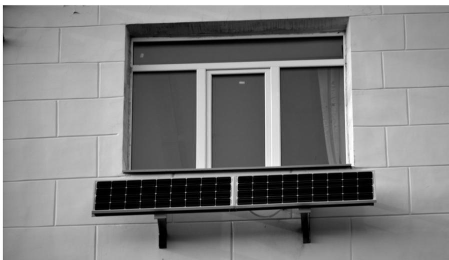
**Рис. 3.** Внешний вид солнечных батарей, находящихся на южной стороне стены учебного корпуса №2 ДВГУПС
